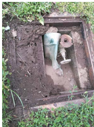
vnitřek – vybetonovaná šachta s ocelovým kohoutem
